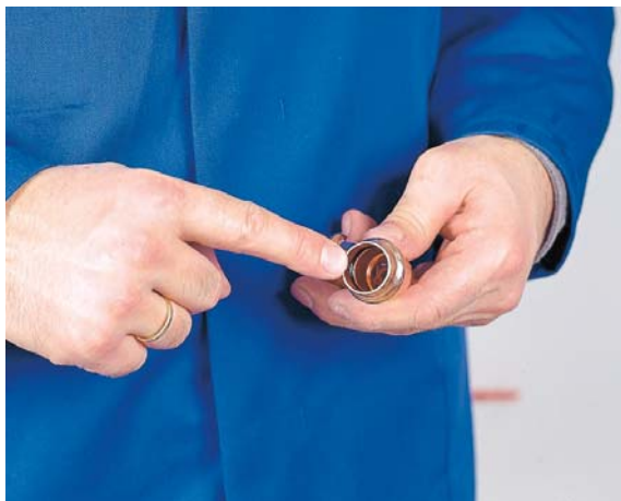
Rys.6.4.3. Sprawdzić, czy łącznik jest czysty oraz prawidłowość położenia uszczelki.
