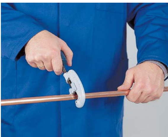
Rys.6.4.1. Obciąć rurę pod kątem prostym za pomocą obcinaka.
